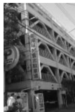
丸亀町商店街振興組合事務所がある丸亀町町営北駐車場。この屋上に無線親機を設置
